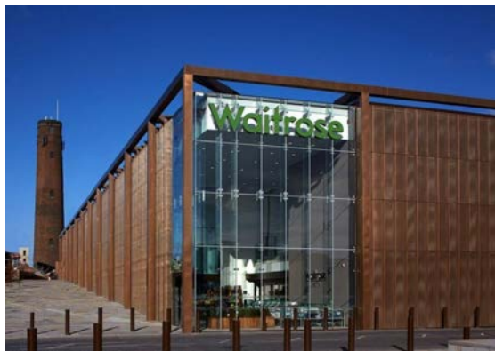
Velká Británie | Chester | fasáda z děrovaného bronzového plechu
