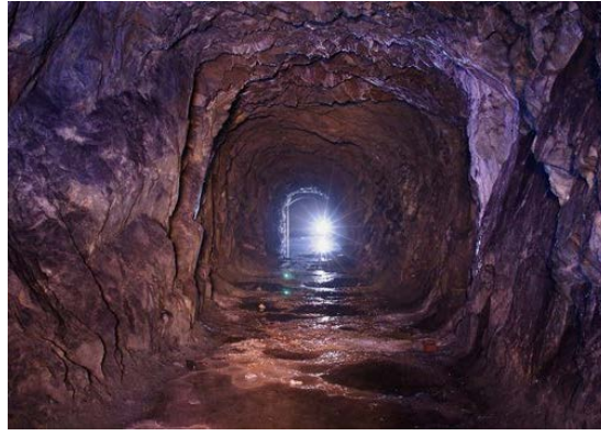
možné zpřístupnění štol
